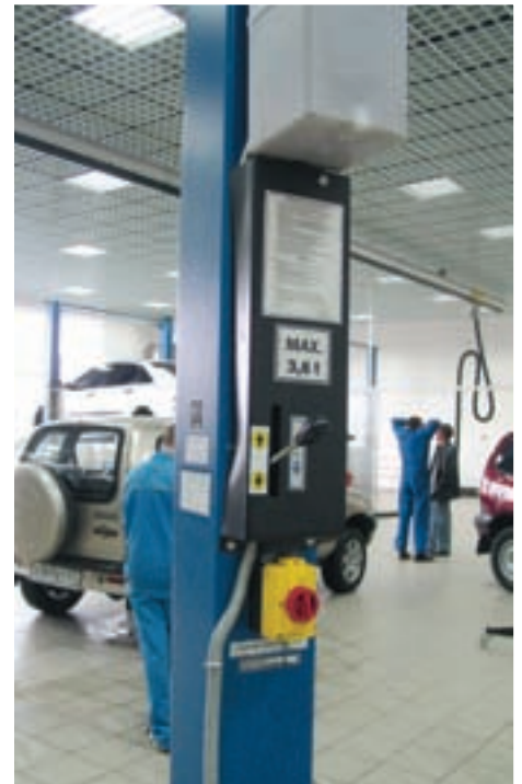
Пульт управления работой подъемника.
